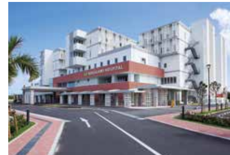
写真1 アプローチからの外観。
