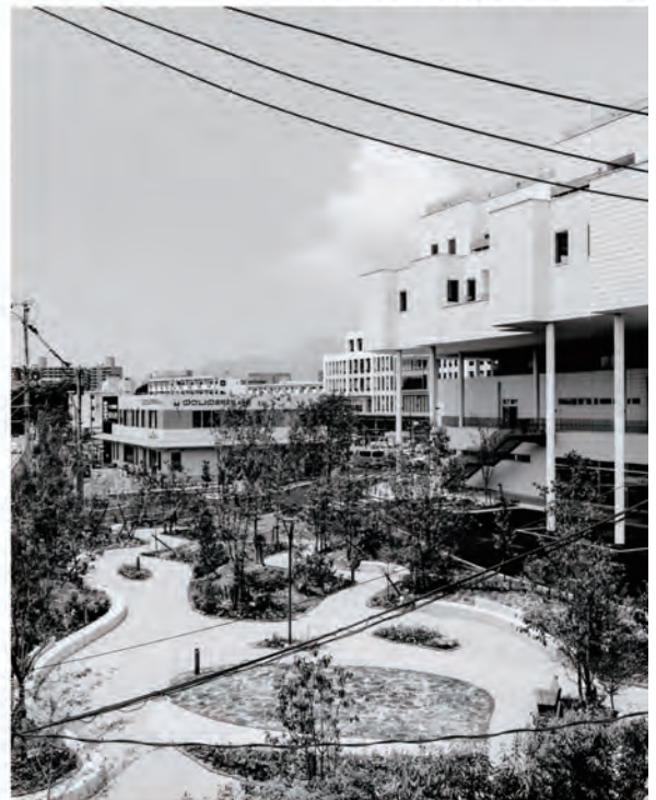
病棟と一体化したランドスケープ
