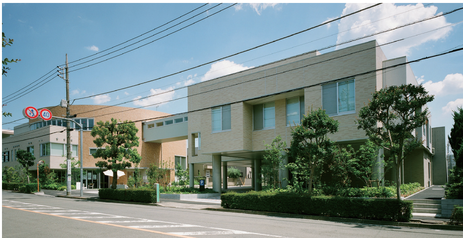
品川道路よりA棟とC棟がつながりゲートとなる
