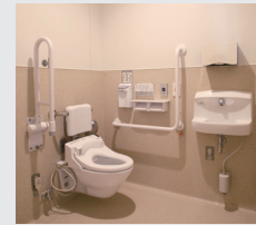
【床巻き上げ】 床シート材仕上げを巻き上げ、床壁に入隅をつくらず清掃性を向上させる
