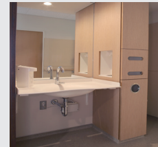
【PPE 収納】 病室近傍の洗面スペースに付属して個人防護具を保管できる収納を設ける
