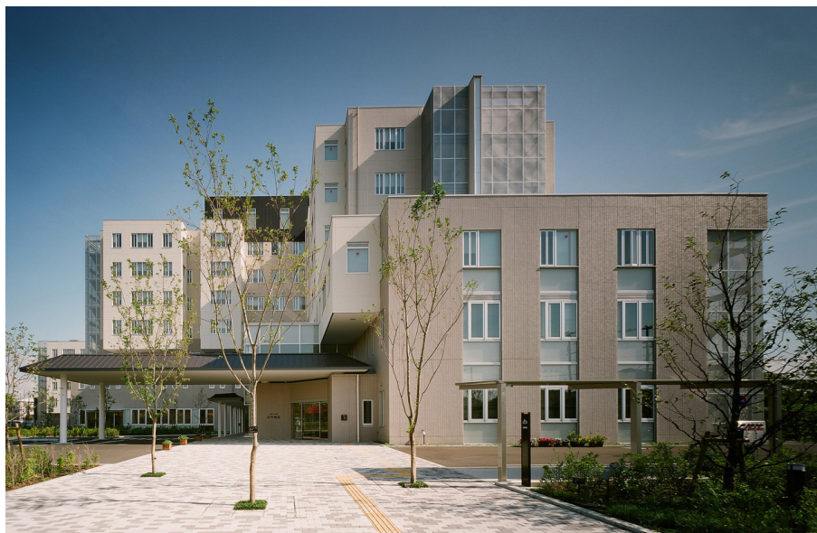
南側公園から樹木帯・街路がつながる西面メインアプローチ、キャノピー
