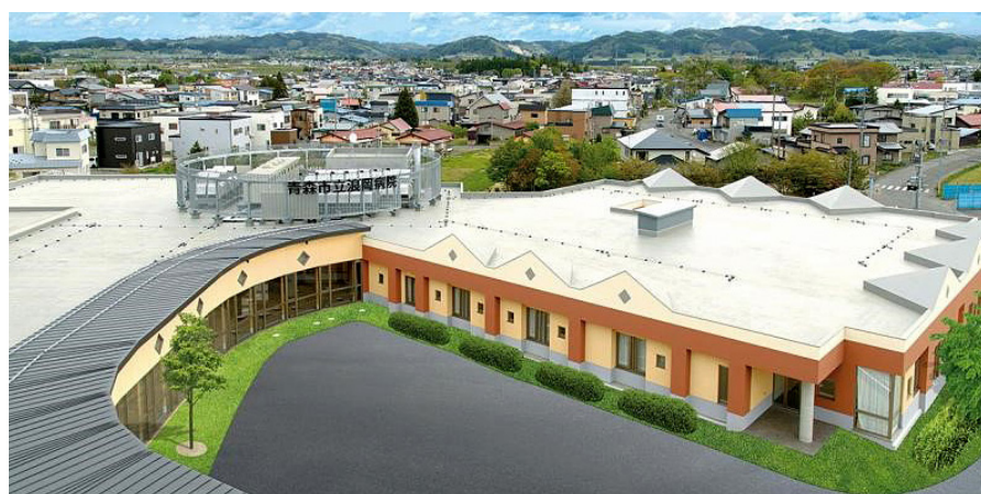
モールと病棟に囲われた広場（工事中のため一部 CG 合成 病院ホームページより）
