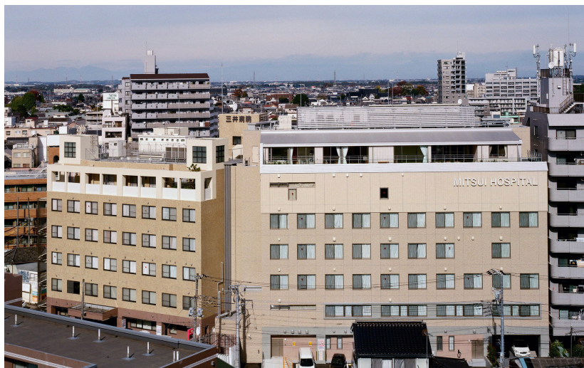
南側外観(左側本館/右側増築棟)↑ 既存建物の要素(開口部形状、仕上げ材料の種類や色)を増築棟側へ取込み、一施設として認知してもらえるよう計画しつつも、内部の機能と呼应した水平横長の窓を設けることで、新しい建物としての外観を特徴づけている
