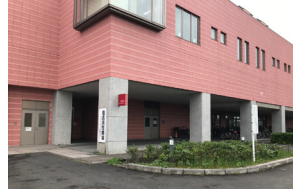
外観 ピロティ(増築前)
