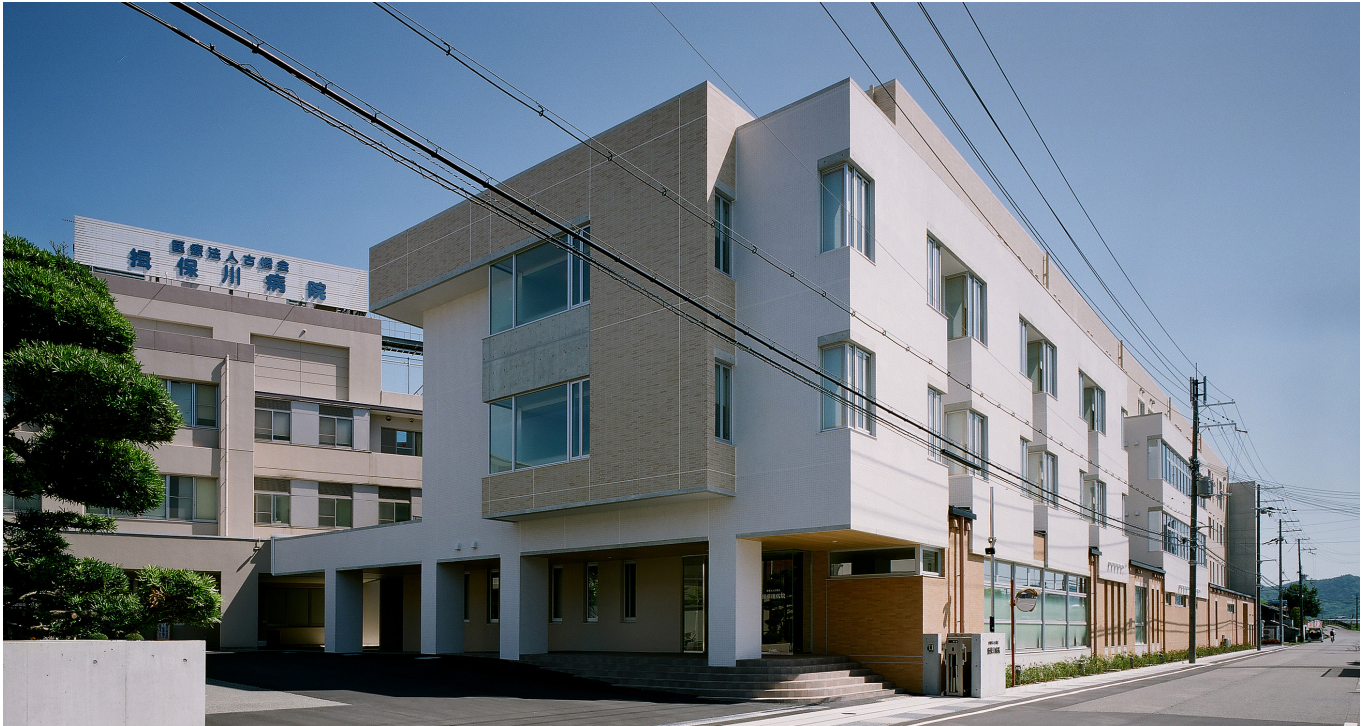
新第1病棟(右)とメインアプローチ、改修既存棟(左奥)
