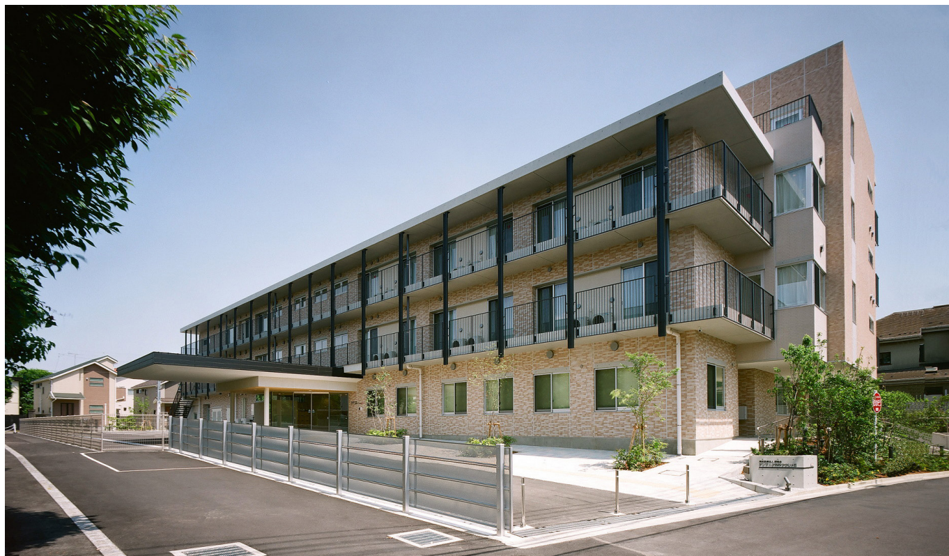
西側外観 メイン玄関へのアプローチ
