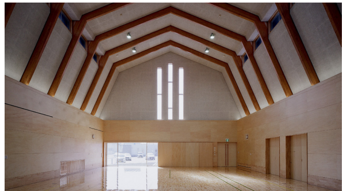
木造屋根の梁部材を現しにした多目的アリーナ
