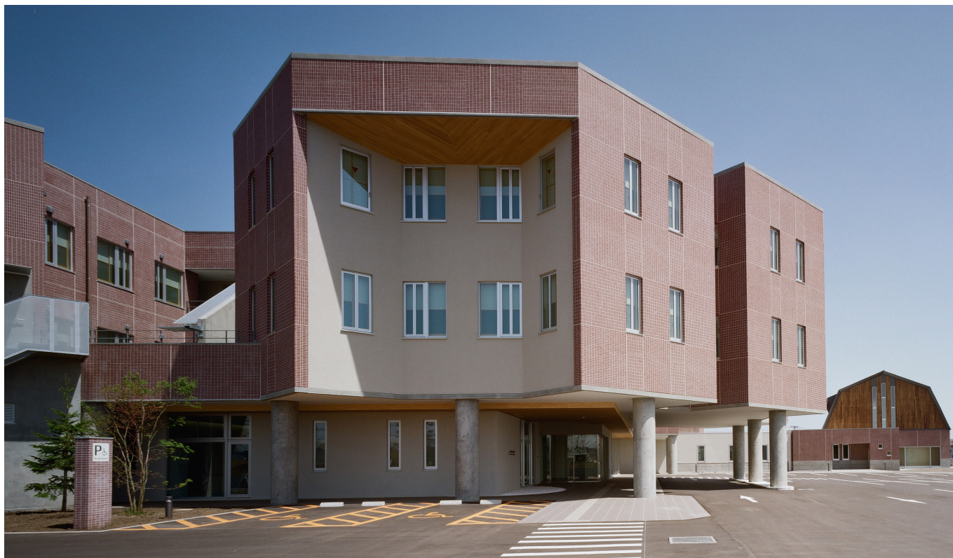
メインアプローチよりエントランスを望むー地域の伝統工芸「南部裂織」の市松柄をイメージしたタイル貼りの外観
