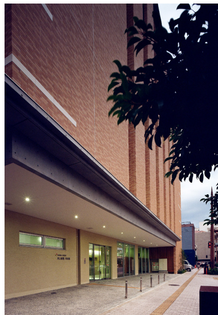
庇が日差しを和らげるメインエントランス
