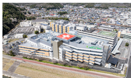
新中央診療棟竣工（2024年）
